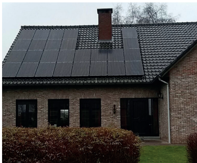
Installatie van Gutami Solar Projects uit de groepsaankoop zonnepanelen
